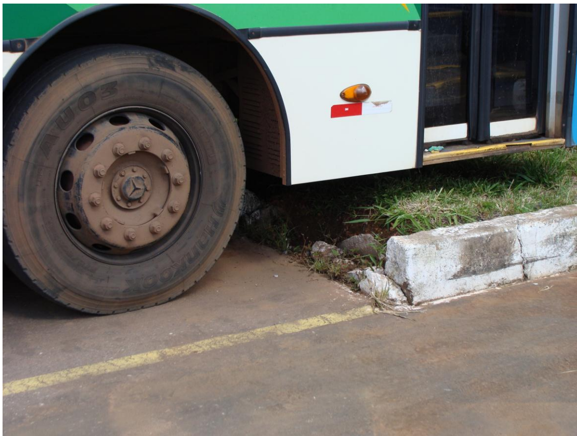
Figura 5 - Baía de ônibus sem limitador no terminal de Brazlândia Veredas.
