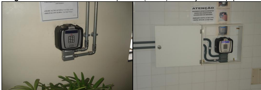
Imagem 03: Coletor Biométrico Inoperante (HBDF) e Proteção do Equipamento (HRC)
