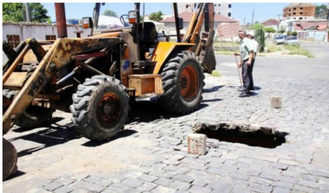
Fig 2 – Desabamento da pavimentação, após falha em tubulação de drenagem executada por 'tunnel liner'.
