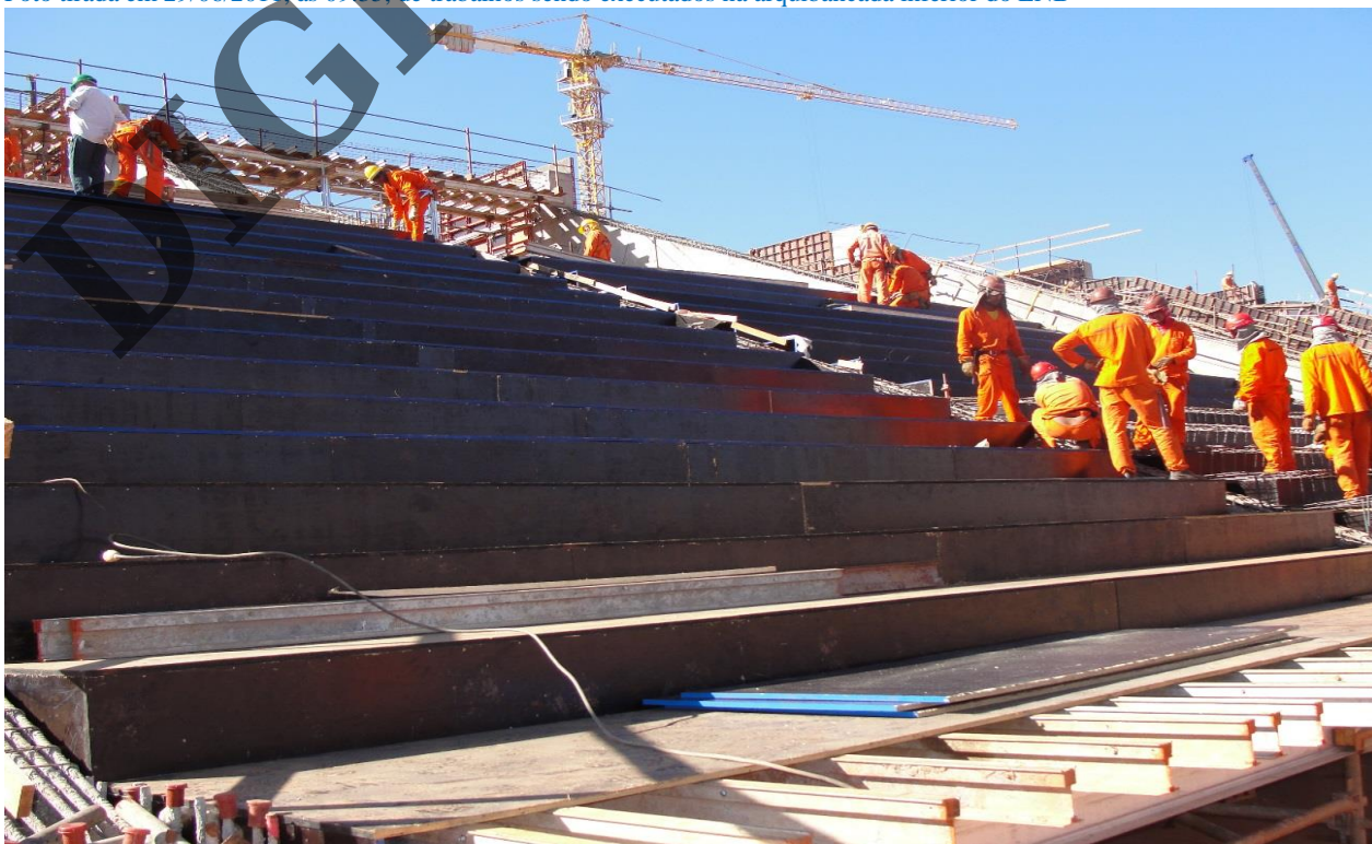
Foto tirada em 29/06/2011, às 09:39, da execução de fôrmas na arquibancada inferior do ENB
