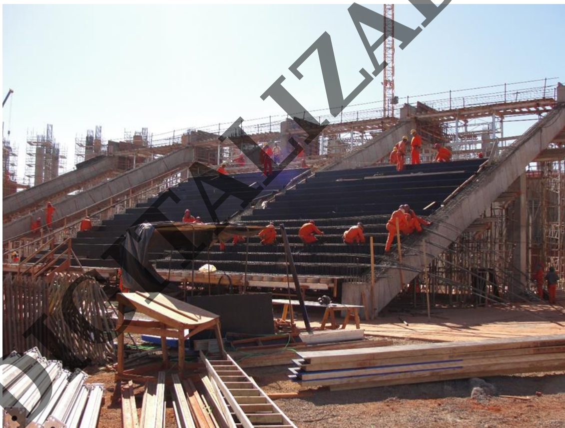
Foto tirada em 29/06/2011, às 09:35, mostrando serviços de armação da arquibancada inferior
