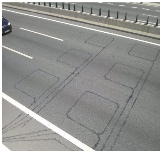
Imagem 1 – Método intrusivo (laço indutivo embutido na via)
