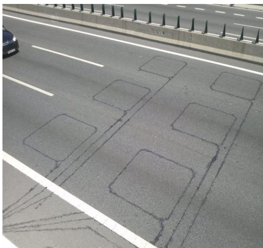
Imagem 1 – Método intrusivo (laço indutivo embutido na via)
