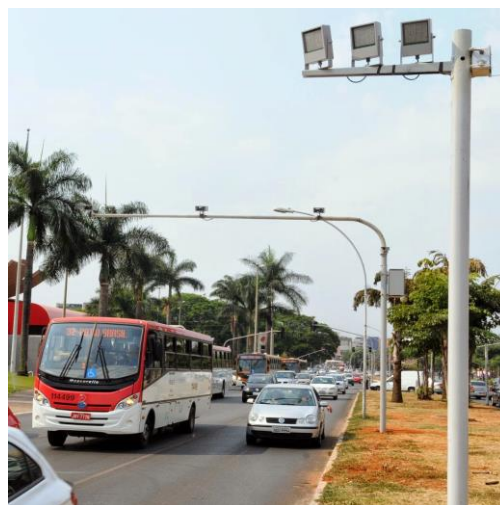
Imagem 2 – Método não intrusivo (sensor ótico instalado sobre a via)
