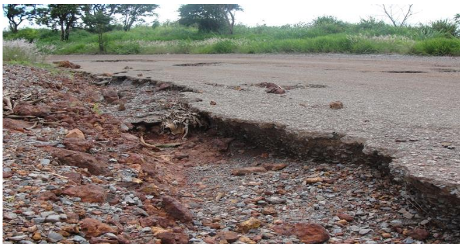
Foto 2 – Degradação da base das vias decorrente da paralisação das obras.
