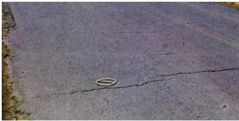
Foto 01: trinca isolada - transversal
