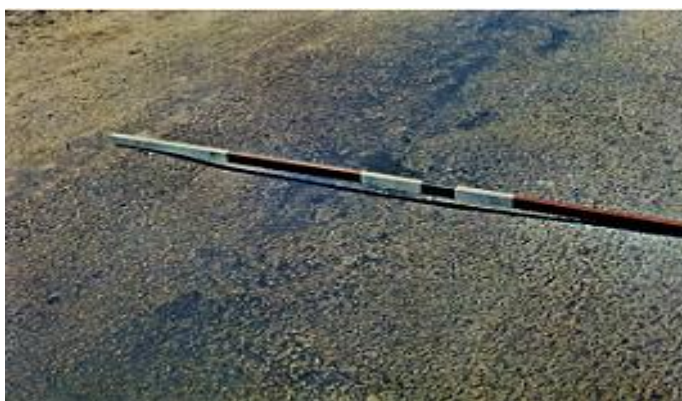
Foto 06: afundamento local
