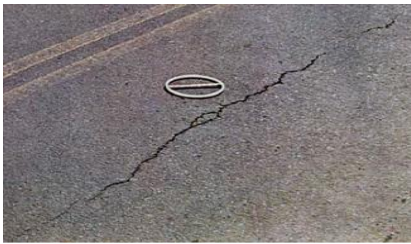
Foto 02: trinca isolada - longitudinal
