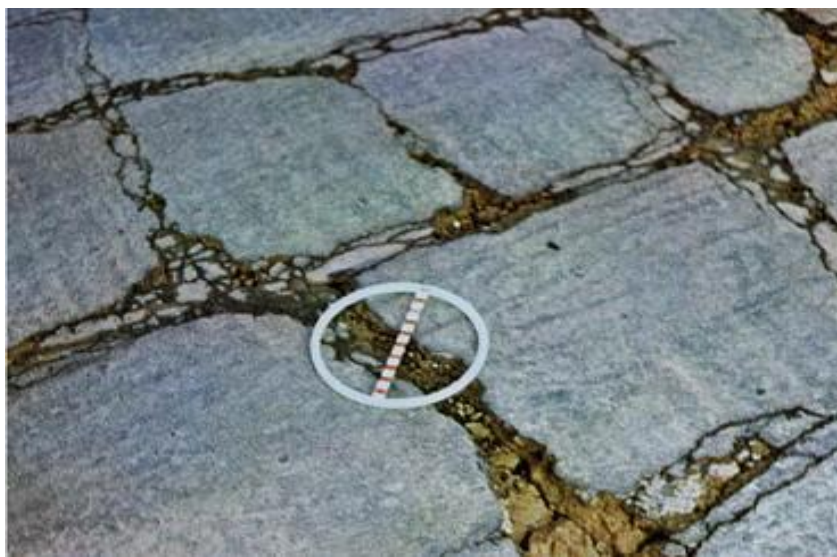
Foto 04: trinca interligada – tipo bloco
