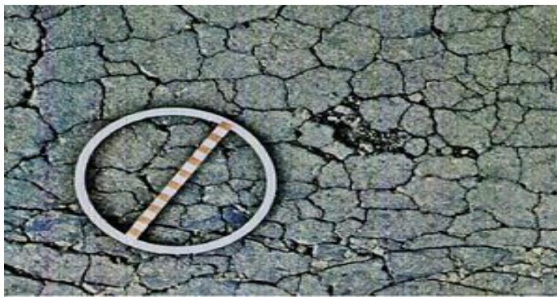
Foto 03: trinca interligada – tipo jacaré
