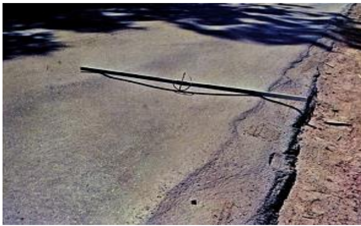
Foto 05: afundamento de trilha de corda
