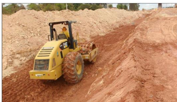
Figura 26 – Compactação mecânica de vala. Fonte: Relatório fotográfico da 26ª medição (DA_96).
