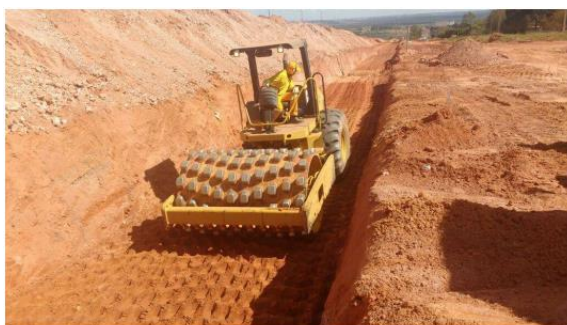
Figura 20 - Compactação mecânica de vala com utilização do rolo compactador. Fonte: Relatório Fotográfico da 24ª Medição (DA_94).
