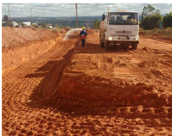
Figura 22 – Trecho de vala sendo umidificado com detalhe do acesso adaptado para o ingresso do rolo compactador. Fonte: Relatório Fotográfico da 24ª Medição (DA_94)
