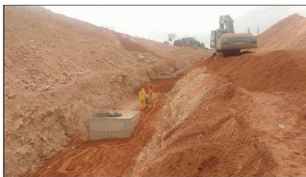
Figura 18 - Reaterro manual de vala. Fonte: Relatório fotográfico da 26ª medição (DA_96).
