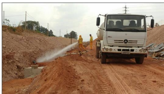
Figura 25 – Umedecimento de material para compactação de trecho da vala. Fonte: Relatório fotográfico da 26ª medição (DA_96).
