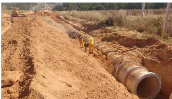
Figura 17 – Compactação manual com sapo mecânico ou soquete vibratório. Fonte: Relatório Fotográfico da 24ª Medição (DA_94).
