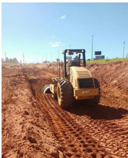
Figura 19 - Compactação mecânica de vala com utilização do rolo compactador. Fonte: Relatório Fotográfico da 24ª Medição (DA_94).
