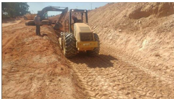
Figura 21 – Compactação mecânica da vala com rolo compactador. Fonte: Relatório Fotográfico da 25ª Medição (DA_95)
