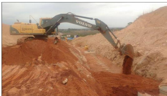
Figura 24– Lançamento de material (enchimento) com escavadeira hidráulica. Fonte: Relatório fotográfico da 26ª medição (DA_96).
