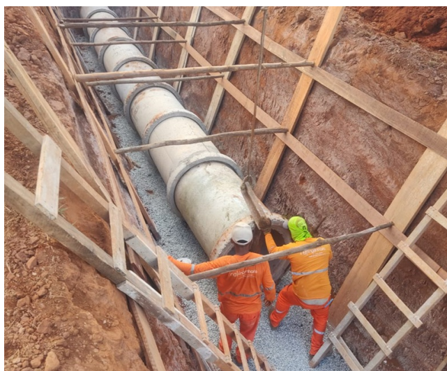
Figura 05 - Execução de rede de drenagem
