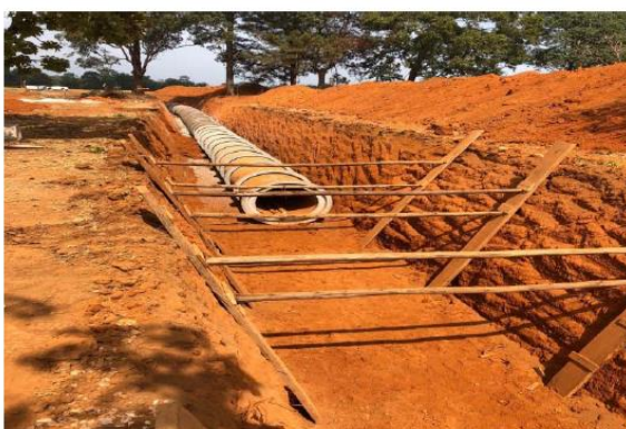
Figura 63: Exemplos de escoramentos sem longarinas na 7ª medição.
