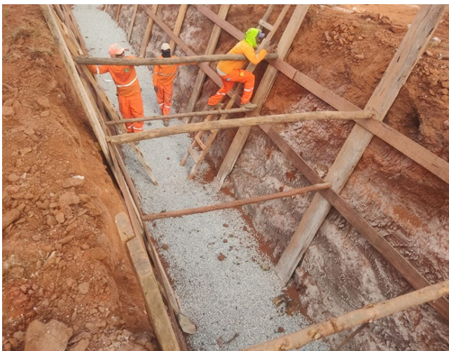
Figura 04 - Execução de rede de drenagem
