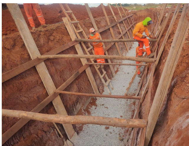
Figura 05 - Execução de rede de drenagem
