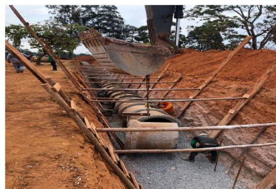
Figura 63: Exemplos de escoramentos sem longarinas na 7ª medição.
