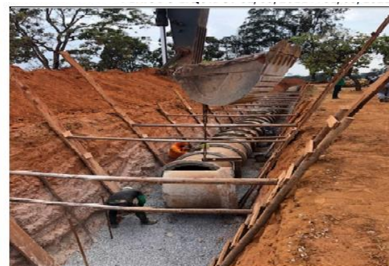
Figura 64: Exemplos de escoramentos sem longarinas na 9ª medição.
