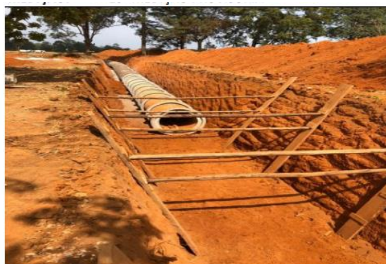
Figura 64: Exemplos de escoramentos sem longarinas na 9ª medição.
