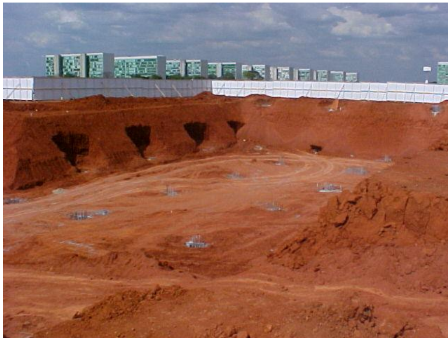
Fig. 6 - Escavação do prédio do castelo d'água mostrando os tubulões em fase de concretagem
