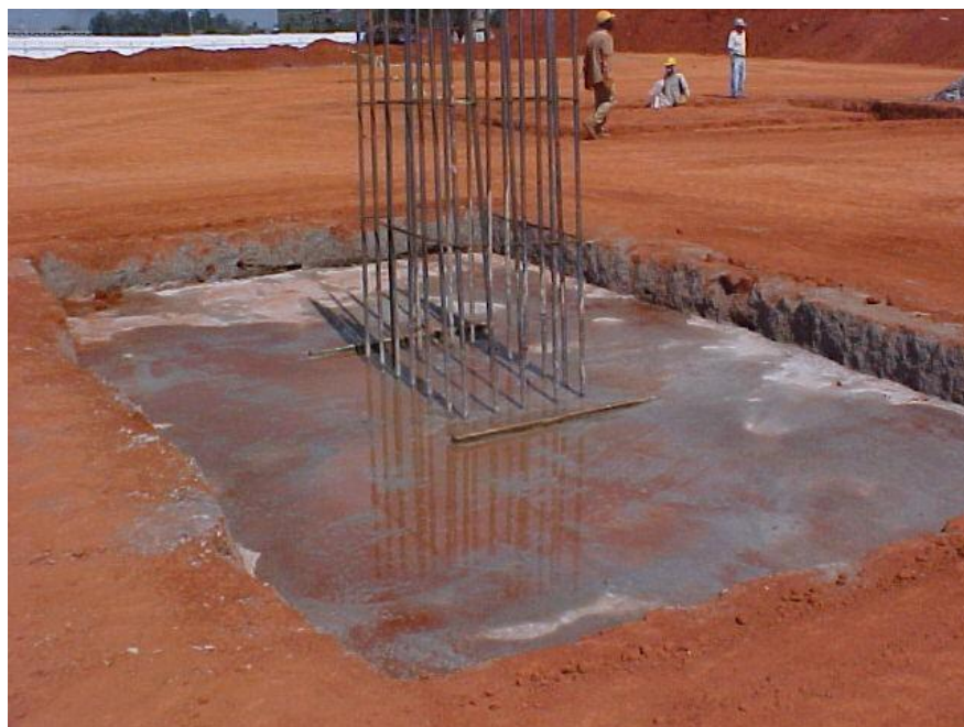
Fig. 5 - Bloco de fundação concretado no prédio principal
